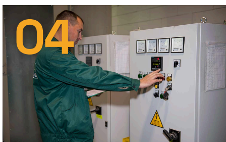
04 Controllo trattamento termico
